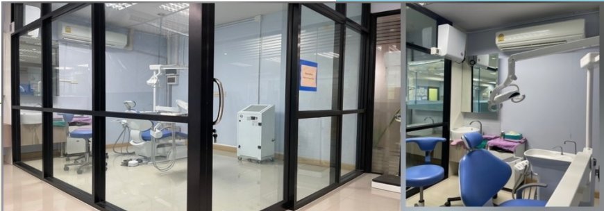
ตรวจรับห้องระบบระบายอากาศ TYPE B
