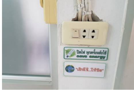
ป้ายกระตุ้นเตือนประหยัดพลังงานไฟฟ้า
